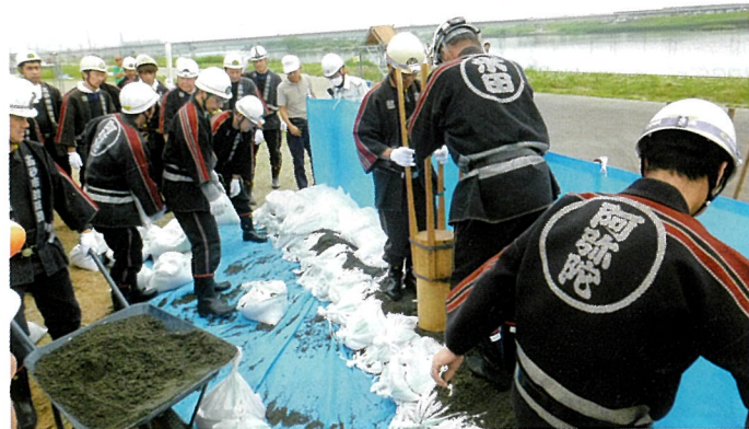
改良積み土のう工法作製訓練
